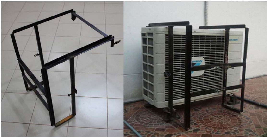
รูปที่ 3.1 โครงสร้างสำหรับติดตั้งมอเตอร์พัดลมของแอร์อินเวอร์เตอร์
