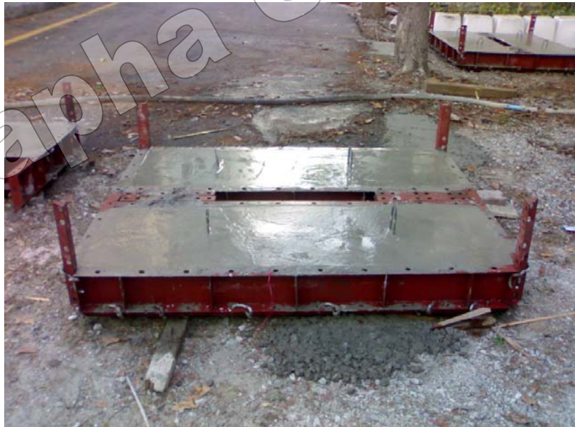
รูปที่ ข-28 แสดงพื้นคอนกรีตที่เพิ่งเทลงแบบหล่อเสร็จ
