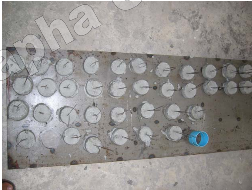
รูปที่ ข-24 แสดงลูกปูนสำหรับเพื่อระยะ Covering ของไม้ไฟที่เสริมในพื้นที่คอนกรีต
