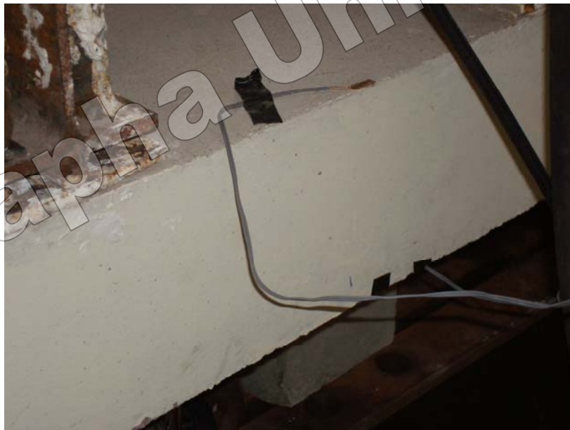
รูปที่ 3.19 แสดงการติดตั้ง Strain Gauge ที่ด้านบน และด้านล่างผิวคอนกรีต
