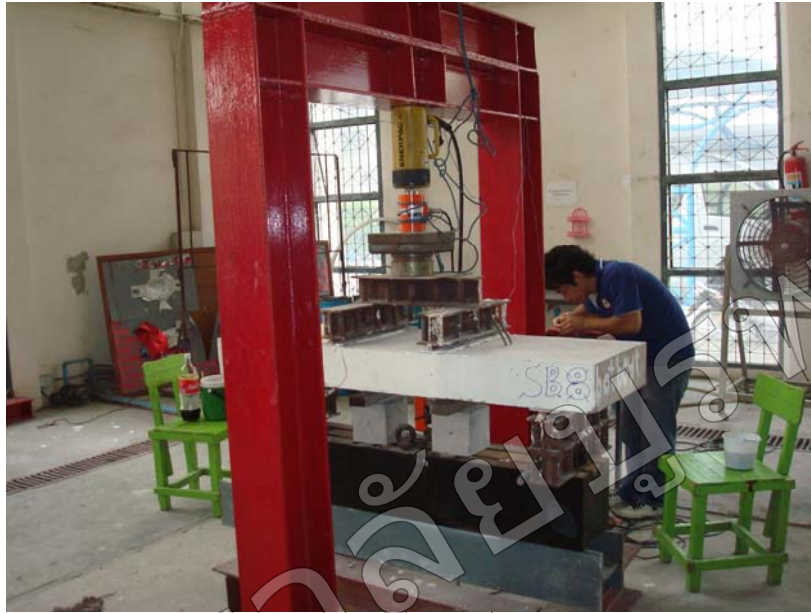
รูปที่ 3.20 แสดงการติดตั้งแผ่นพื้นก่อนการทดสอบ
